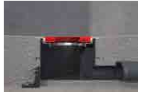
15. Bündiger Abschluss der Beschichtung mit dem Edelstahlaufsatzring.
